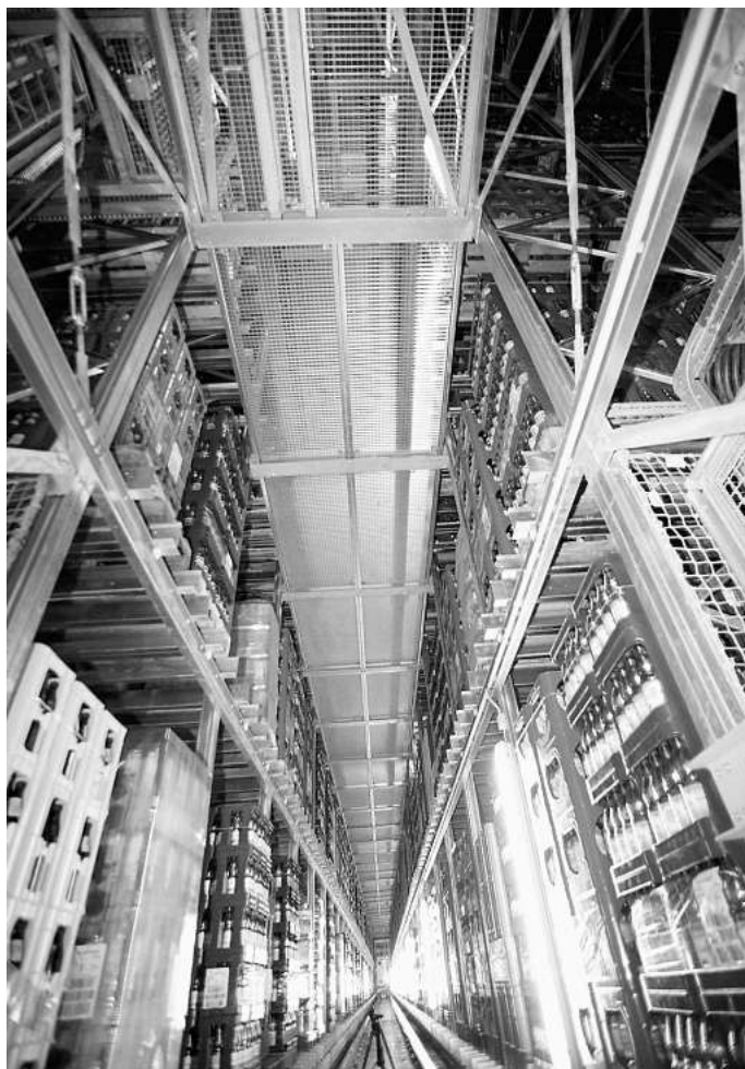
Das neue Regallager bietet auf 8400 Quadratmetern Platz für insgesamt 38688 Paletten.
