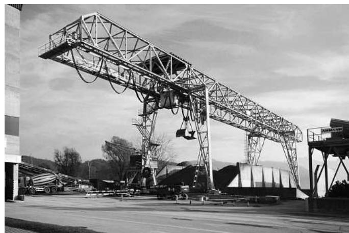
Der Portalkran bei der Sand und Kies AG Horw/Luzern wurde von der Marti-Dytan AG umgebaut und auf den neuesten Stand der Technik gebracht. (Bilder: Marti-Dytan AG)
