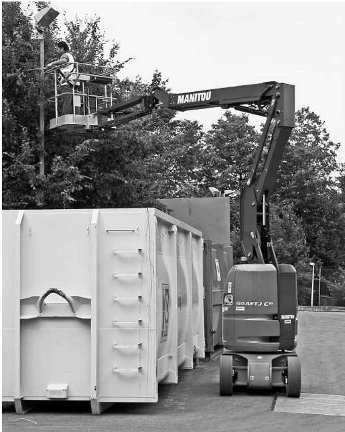
Die 120 AETJ 3D wird auch für den Unterhalt im Freien eingesetzt.
