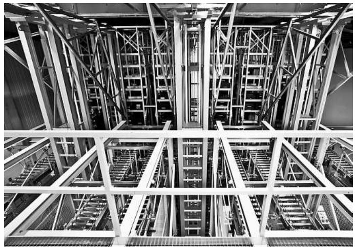
Das 4-gassige AKL bietet nun Kapazität für über 45 000 Behälter.
